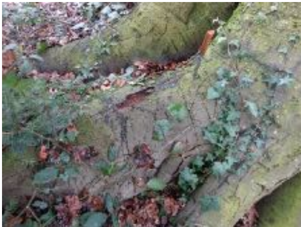
lekpits en scheuren
