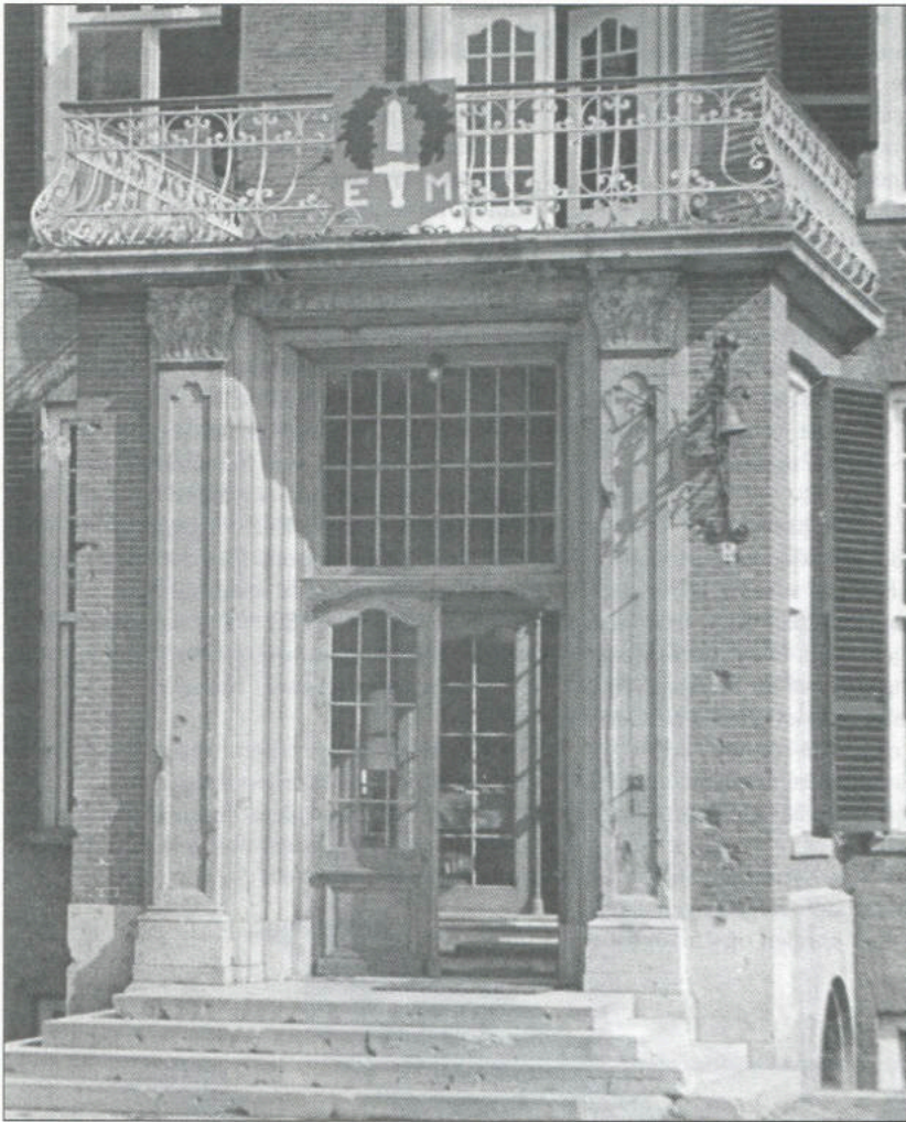
De ingangspartij van kasteel Zypendaal in 1954: de kogelgaten uit de oorlog zijn nog zichtbaar. Foto: E.W't Sas
