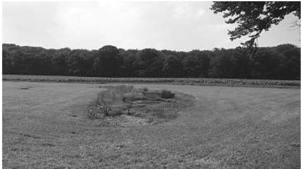
Regenwaterverdeelput op de weide in het NO van Zypendaal voor de wadi's bij Cranevelt.
