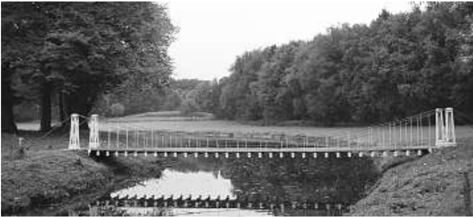
De ijzeren brug op het landgoed Enghuizen. Waar kennen we dat model van?
