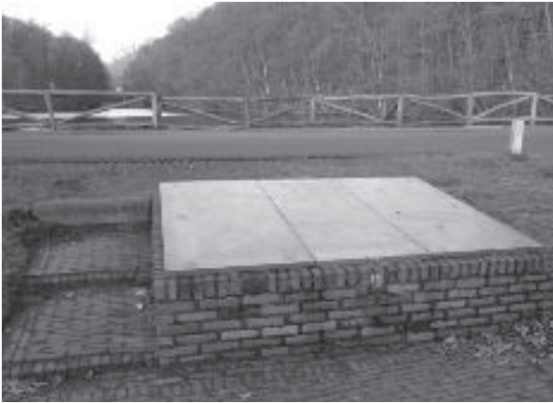
De put naast de Parkweg waarin de twee waterrammen zijn opgesteld die de waterdruk leveren voor de fontein aan de andere kant van de Grote Vijver.
