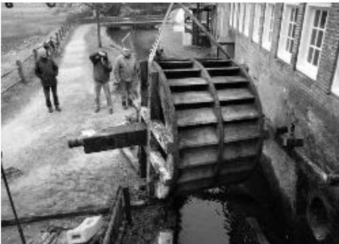
Afbraak van de oude waterradinstallatie. Het rad wordt uit de
